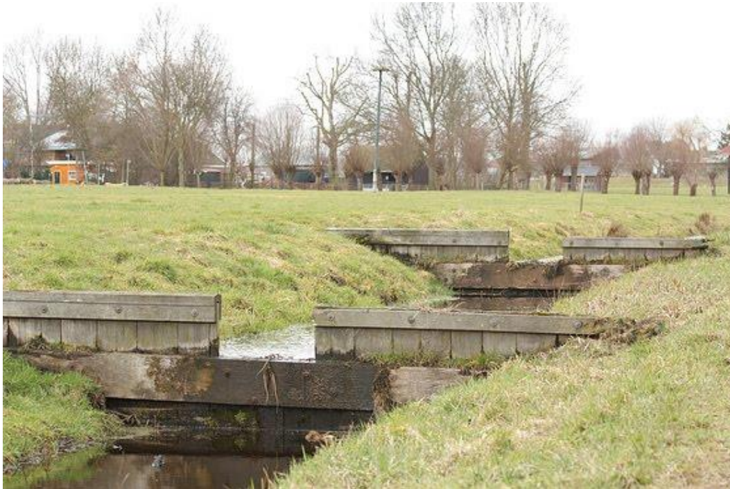
Figuur 30: Schotten in grachten vermijden dat al het water wegstroomt en zorgen voor voldoende infiltratie.
