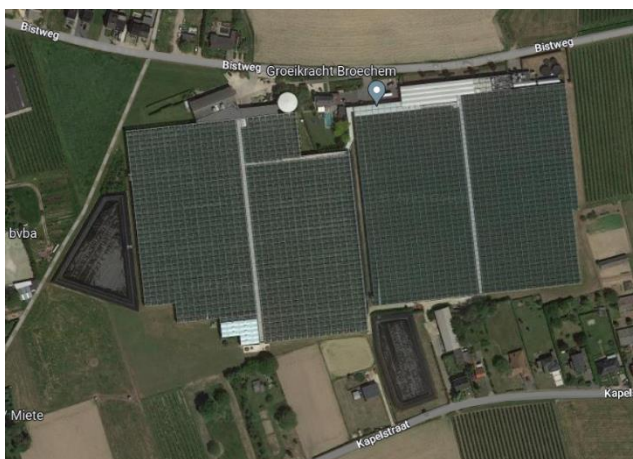
Figuur 52: Groeikracht Broechem heeft 2 opvangbekkens voor hergebruik regenwater.
