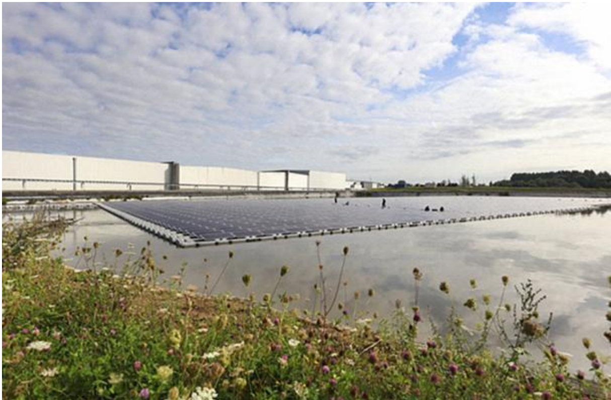
Figuur 36: Bufferbekken voor hergebruik (met zonnepanelen) van het bedrijf Ardo (bron: Vlakwa.be)
