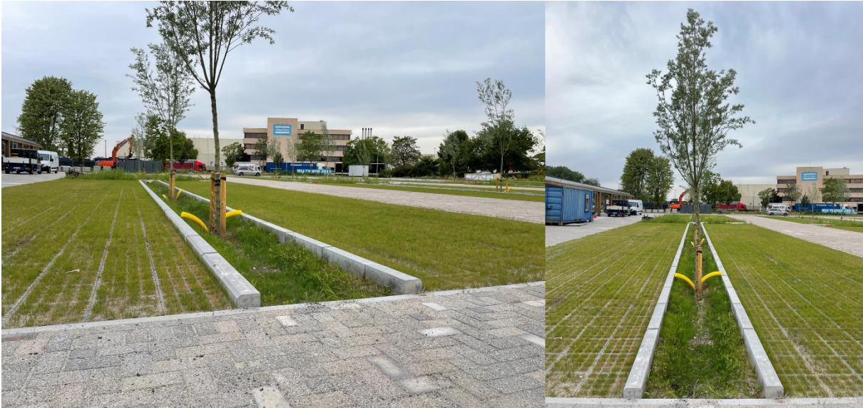
Figuur 46: Parking Aquafin te Aartselaar met waterdoorlatende parkeervakken en infiltratiestrook.
