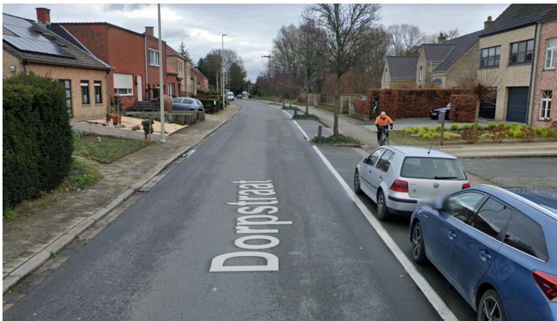
Figuur 56: Wegprofiel zuidelijke Dorpstraat (Google Streetview, december 2020)
