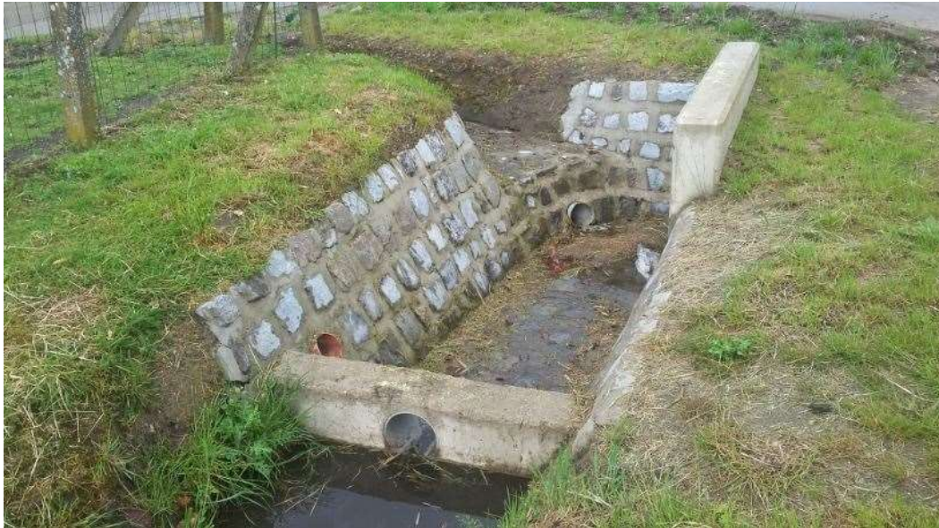
Figuur 38: RWA-as met debietsbeperking te Balen (bron: blauwgroenvlaanderen.be)
